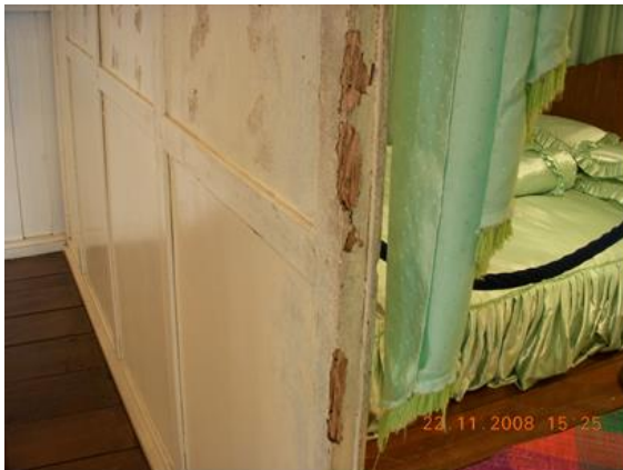
Gambar 4: Pereputan oleh serangan anai-anai pada dinding dalam bangunan Kajian Kes 1. (Sumber : Penulis)
