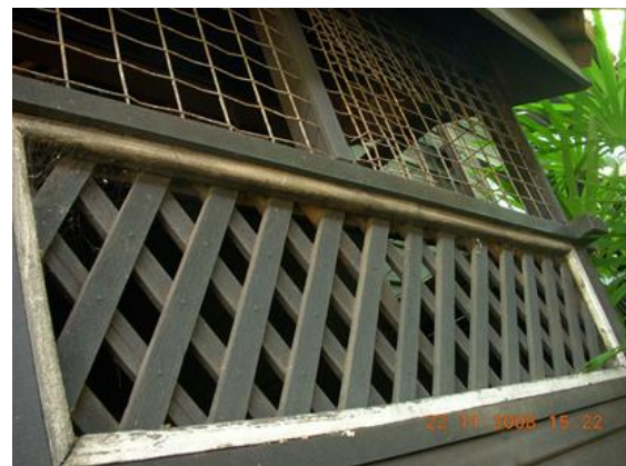
Gambar 6: Lubang udara dikekalkan walaupun mungkin menjejaskan kualiti artifak dalam bangunan Kajian Kes 1. (Sumber : Penulis)
